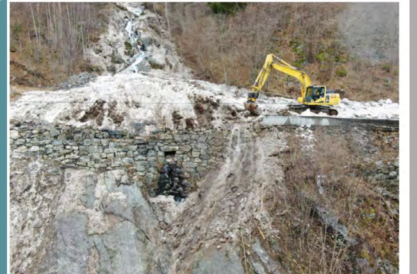
Figur 5 - Skredmassar i veg. Merk at støypekant er borte og drenering er tett. Noko vatn går under tørrmuren. Fo
